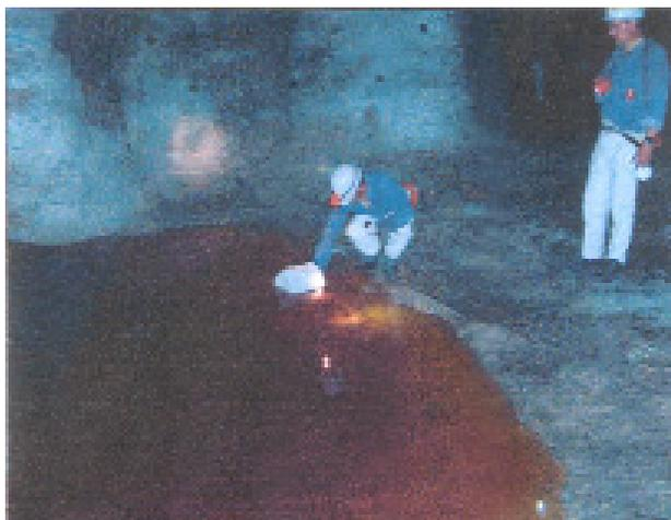
Aus ein paar feuchten Stellen wurden Sümpfe, die ahnen ließen, was da noch auf die Asse zukommen würde. Allein auf der heißen 750er Sohle sind in der Nähe von Einlagerungskammern inzwischen fünf veritable Laugesümpfe entstanden. Dabei sieht einer schon eher aus wie ein kleiner
