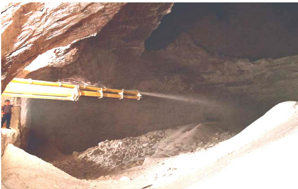
Blick in eine Salzabbaukammer, deren Decke eingebrochen ist. Sie wird per Blasrohrtechnik mit Ronnenburger Haldensalz gefüllt.
